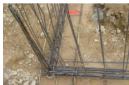
Nœud de chaînage - Continuité mécanique
