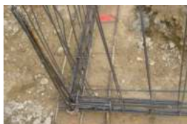
Nœud de chaînage - Continuité mécanique
